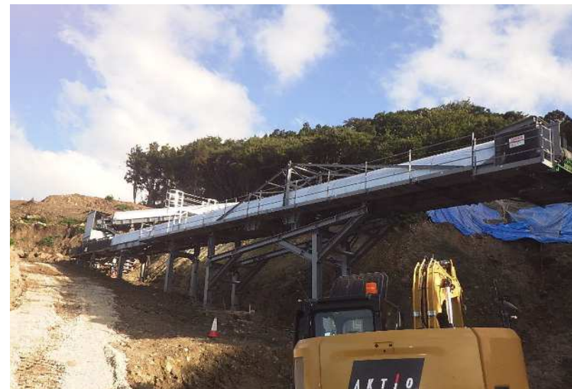
ベルトコンベア 設置完了
